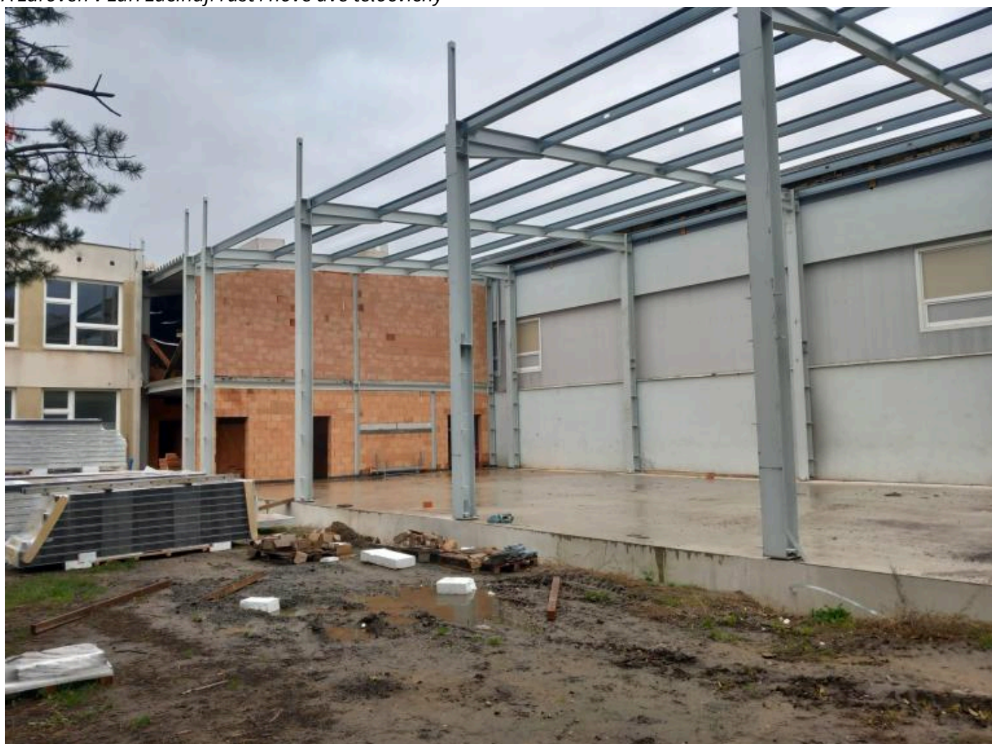
Pohled na budoucí tělocvičny v říjnu
