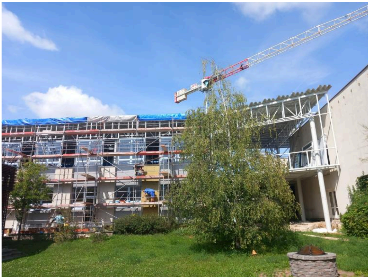
Jsme v srpnu 2024 a postup stavby je nápadně vidět
