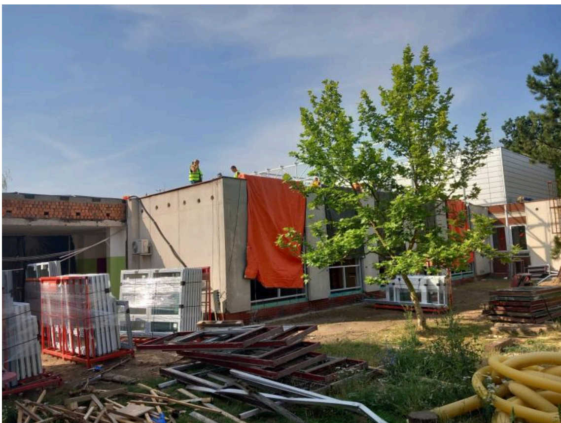
Snímek z července 2024. Dole je pavilon ředitelství bez oken, nahoře začne růst kovová konstrukce nového pavilonu.
