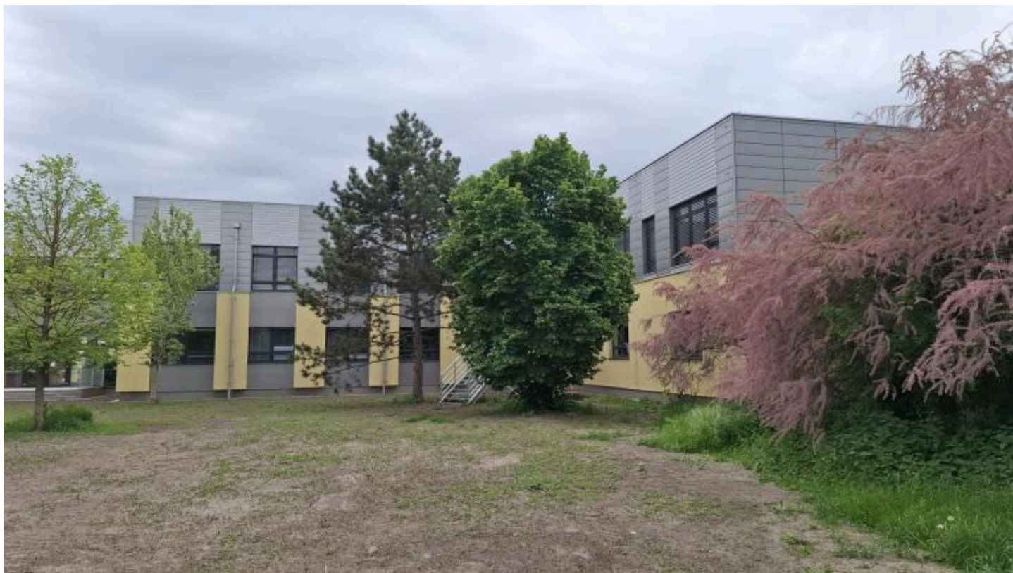
Vnitřní atrium s novými částmi školy po odjezdu techniky
