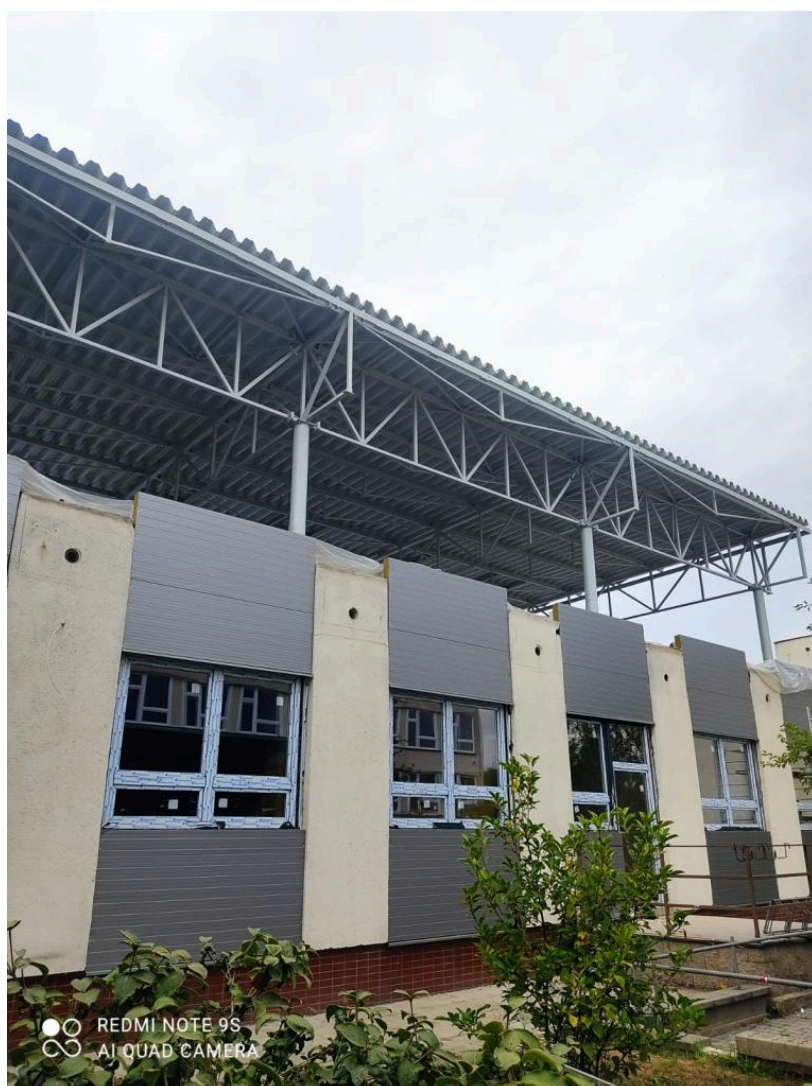
A tady se už nová konstrukce rýsuje
